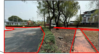
既有瀝青混凝土鋪面及景觀步道拆除範圍
