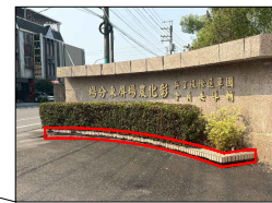
既有花台磁磚打除(施作洗石子)
