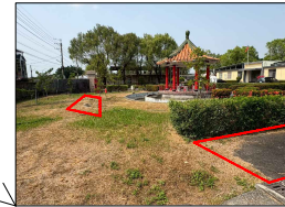
既有瀝青混凝土鋪面拆除範圍/既有樹頭清除修復
